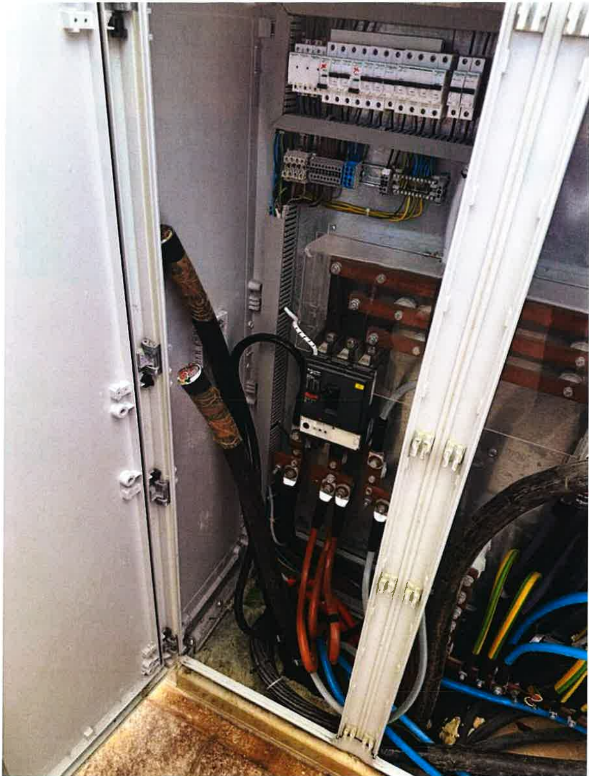
Slika 5. KRO/A.1 - pogled iz ormara 1.
